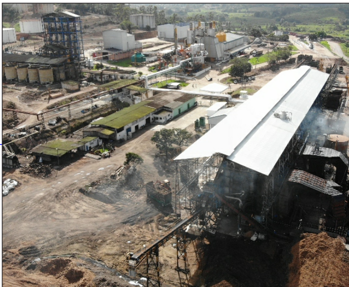
Indústria passa por manutenção e montagem de novos equipamentos
